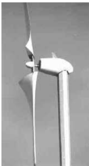
Rys. 13. Turbina wiatrowa o osi poziomej z wirnikiem umieszczonym po stronie zawietrznej
