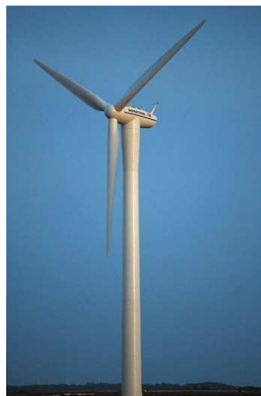
Rys. 15. Siłownia wiatrowa 3 - skrzydłowa o wieży typu tubulama
