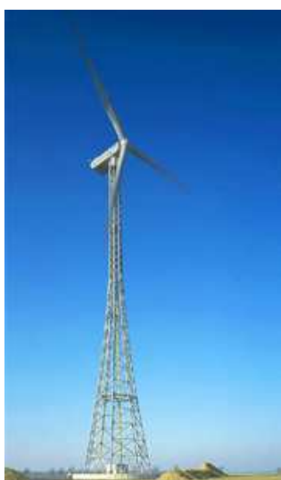
Rys. 16. Siłownia wiatrowa 3 - łopatawa o wieży kratowej
