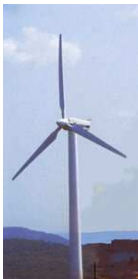
Rys. 14. Turbina wiatrowa o osi poziomej z wirnikiem umieszczonym po stronie nawietrznej
