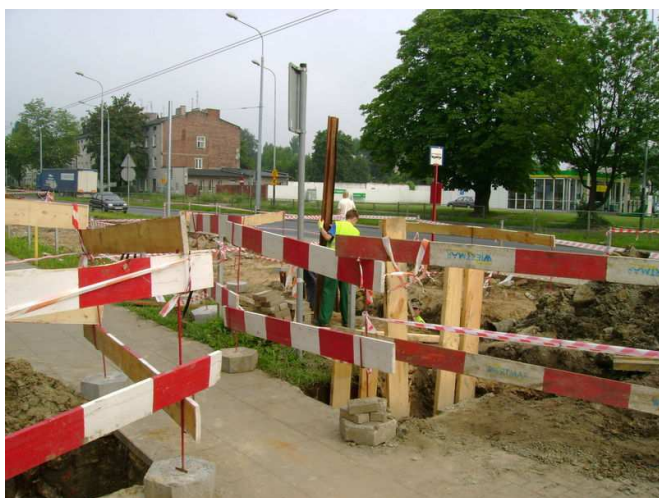
Fot. 13. zabezpieczenie terenu prac budowlanych.
