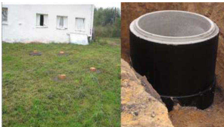
Fot. 3. Zbiornik podziemny
