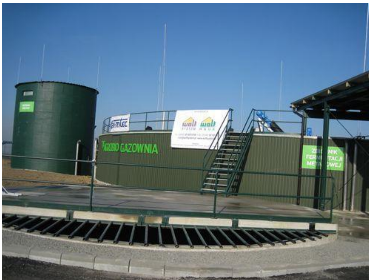
Rys. 6. Biogazownia w Kostkowicach
