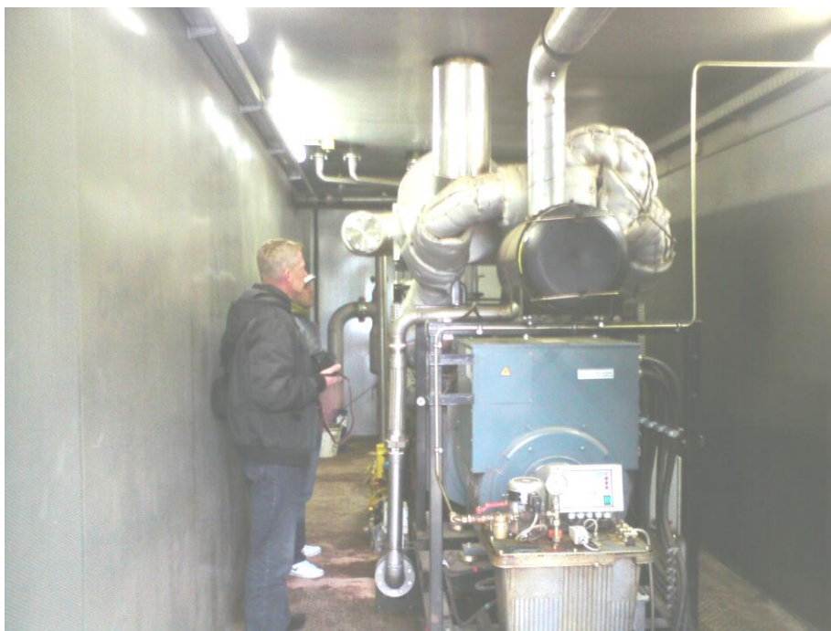
Rys. 52. Generator prądu zasilany silnikiem na biogaz
