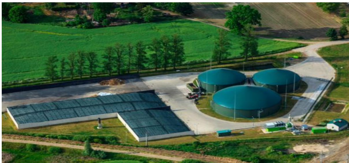
Rys. 22. Biogazownia w Kisielicach
