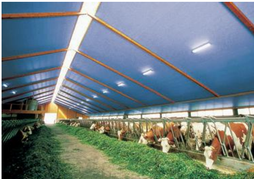
Rys. 9. Przykład izolacji sufitu
