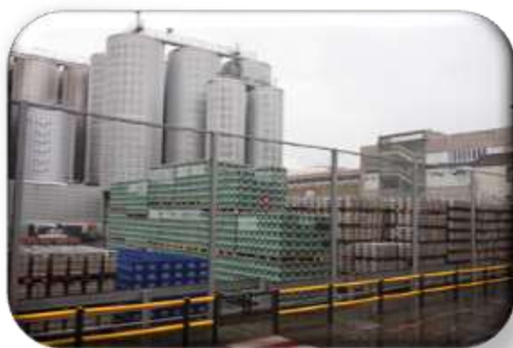
Fot .11. Współczesne kotły warzelne i magazyn wyrobów gotowych
