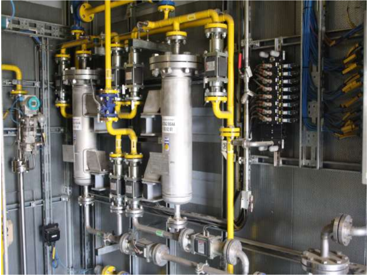
Urządzenia do oczyszczania biogazu, który rurociągiem płynie do Hannoveru
