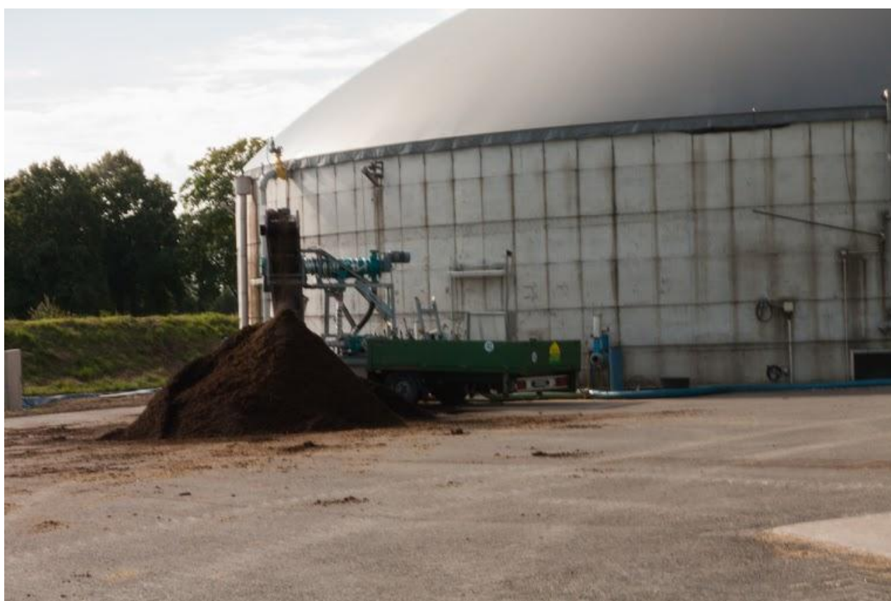
Wytwórnia biogazu w Juhnde
