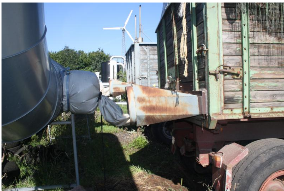
Wykorzystanie ciepła z silnika spalinowego do suszenia zboża
