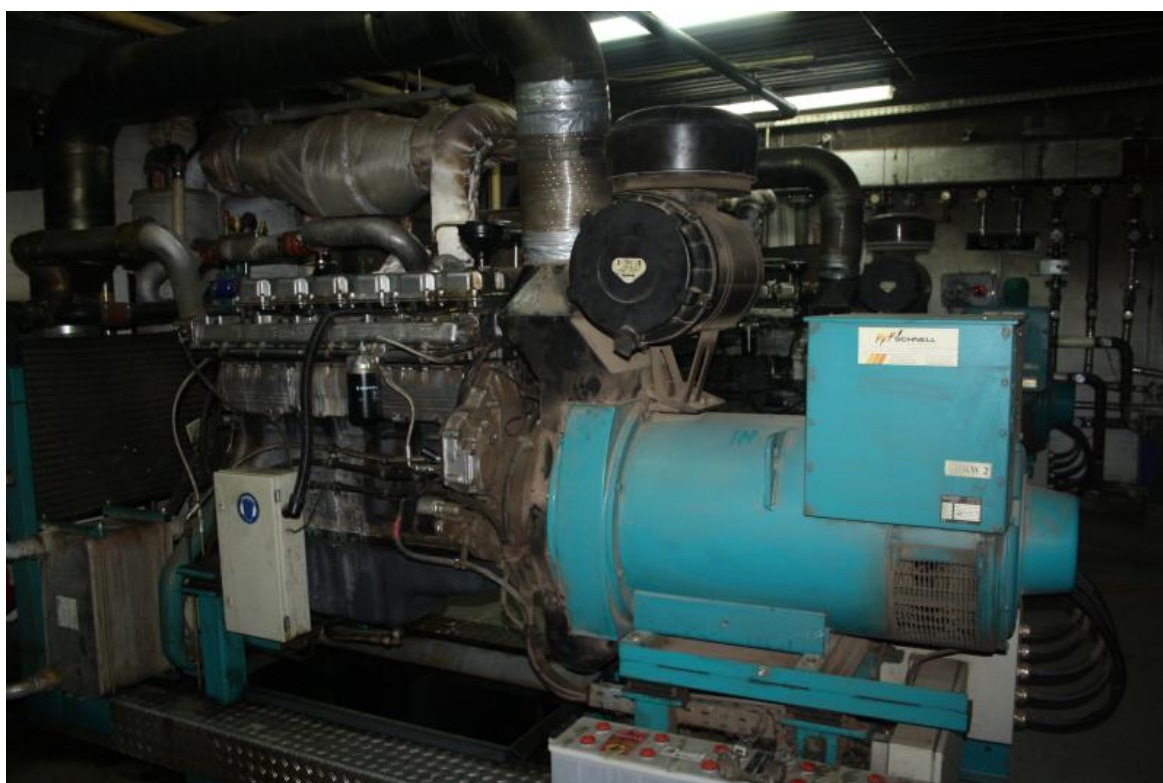
Silnik napędzający generator prądu
